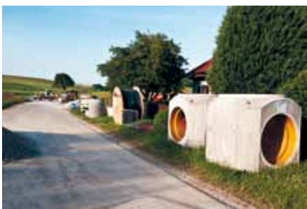
Beginnende Infrastrukturarbeiten in Wiesen
