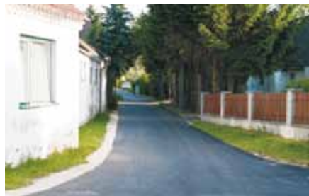
Sanierung der Dorfstraße in Untertiefenbach
