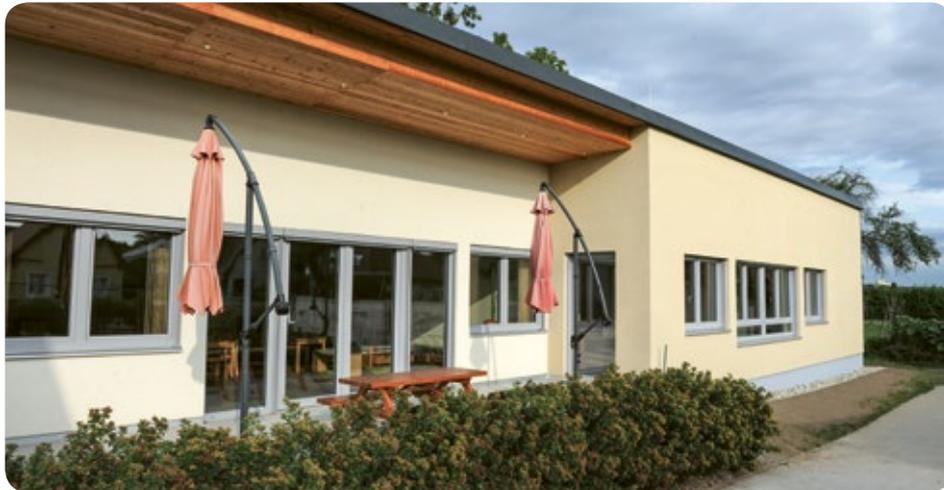
Der Zubau wurde von Mitte Juni bis Ende August fertiggestellt. Errichtet wurde das Holzriegel-Niedrigenergie-Gebäude mit einer neuen ökologischen Technologie: Einblas-Dämmung aus ISO-Stroh und einer natürlichen
