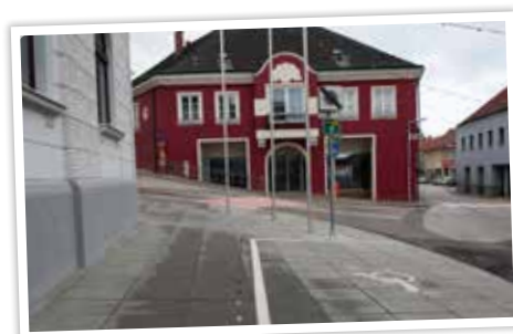
Breiter Gehsteig mit Steinplatten, die den urbanen Charakter unterstützen. Überdachte Radgarage und neu errichteter Stiegenaufgang zur Kirche.
