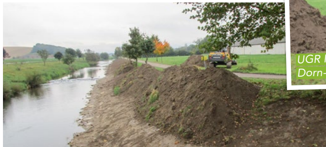
0,5 – 1m hohe Anlandungen unter der Brücke, 4000 m 3 Erde wurden weggebaggert und das Flußbett wird geschont
